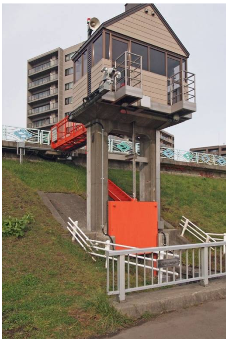
↑ 創成川取水樋門
